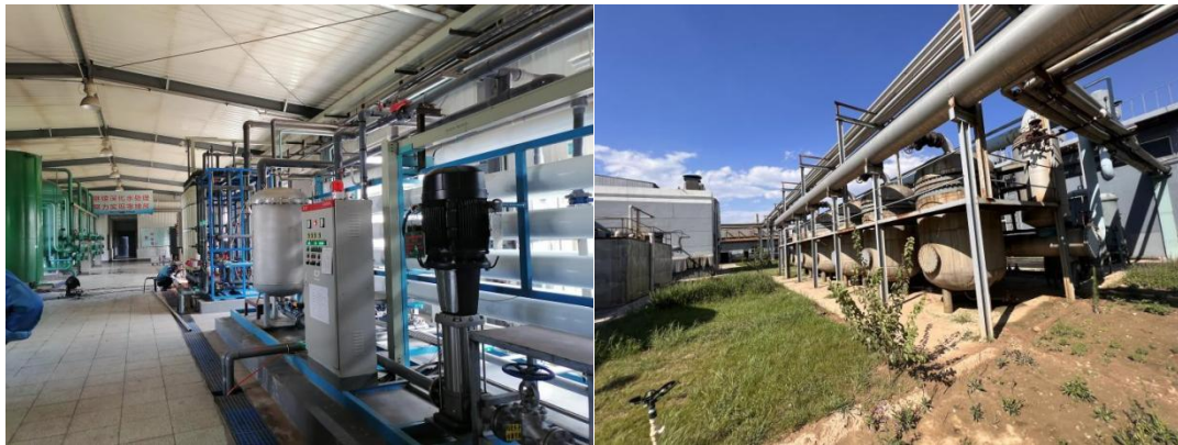
图1.3-1 部分现场勘查及人员访谈照片
