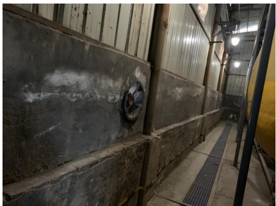
液体库事故水地沟
