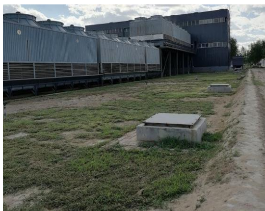
调节池+一清池+二清池
