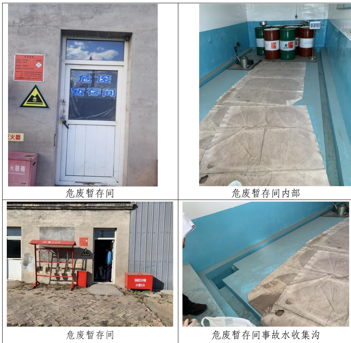
图 5.3-7 危废暂存间情况
