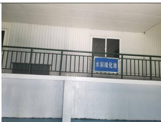
污水处理站水解酸化池
